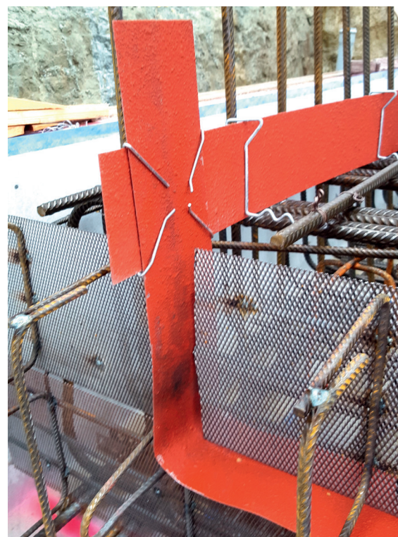
Entwickelt und hergestellt in Birr: Das Robotec-FB Fugenblech.
